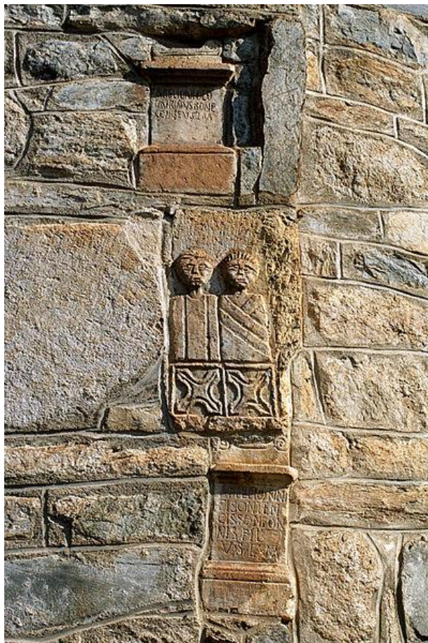
Détail d'un mur de l'église de Saint-Aventin-de-Larboust
